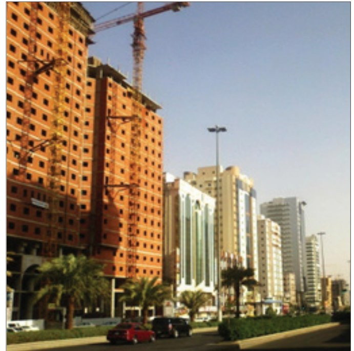
شكل (١٧): اعادة بناء متسارع في الشارع العام بالعزيزية
